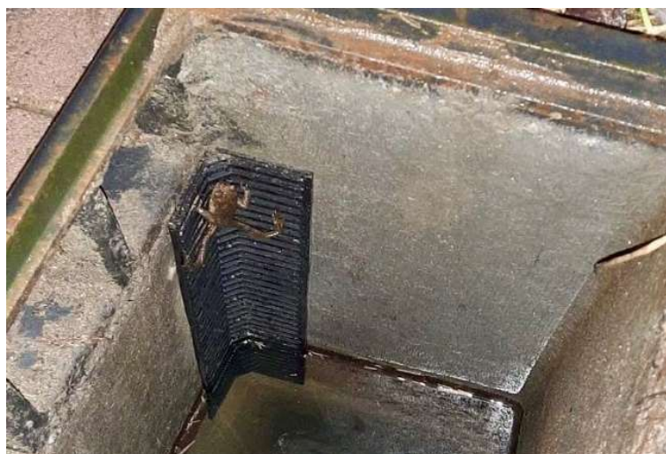
Op verzoek van de afdeling Natuurlijk Delfland heeft de gemeente Delft bijna 200 stuks uittreeladders gemonteerd in trottoirkolken.
