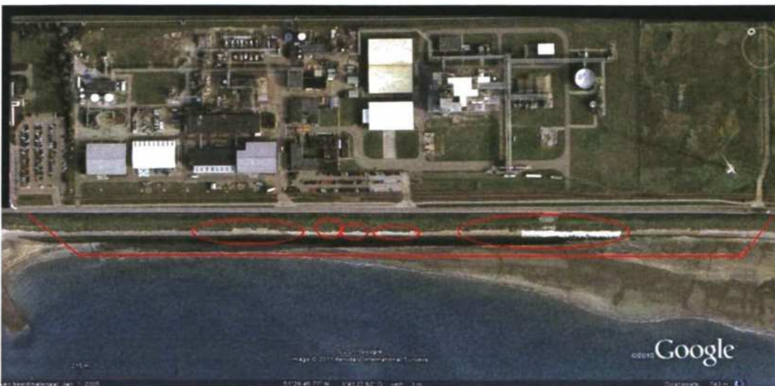
Dijkvak met verzwakte en te repareren gedeelte
