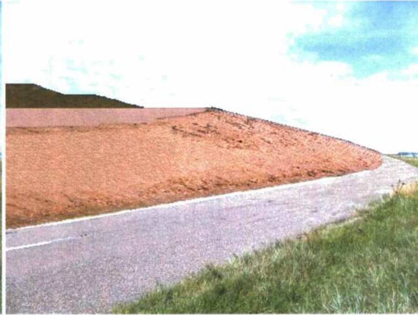
Westelijk duin aan de landzijde na de dijkverzwaring
