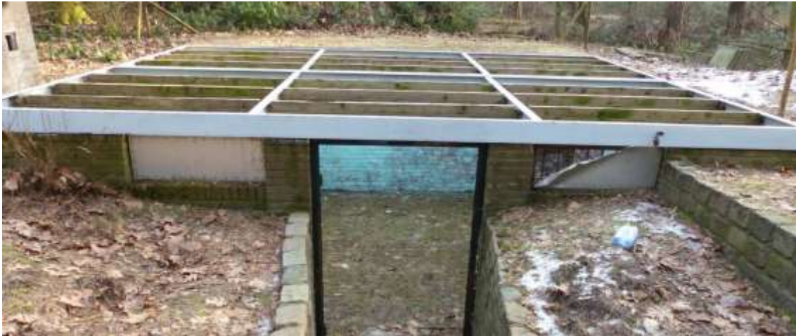
Figuur 16. Het nieuwe frame voor het dak is op de oude kelder geplaatst (foto Erik Korsten).
