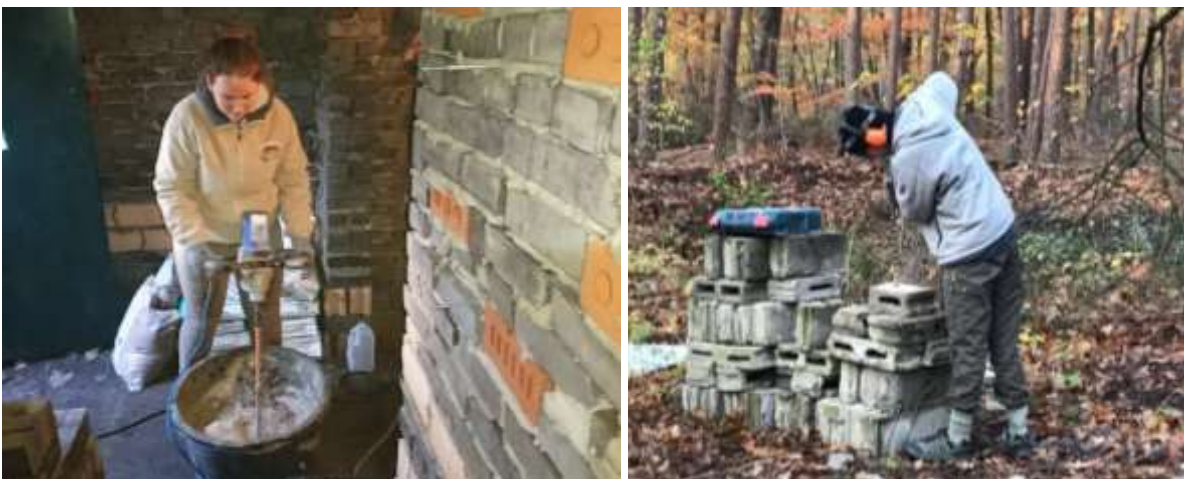
Figuur 21. Het mengen van cement en het voorbereiden van de wegruipstenen (foto's Erik Korsten en Eva Henrard).
