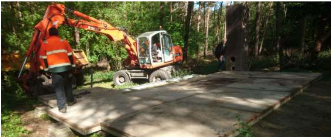
Figuur 17. De dakplaten worden geplaatst (foto Jaap van Kemenade).
