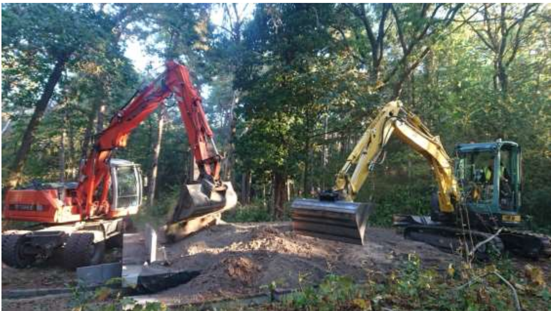
Figuur 18. En de kelder wordt toegedekt met zand (foto Jaap van Kemenade).
