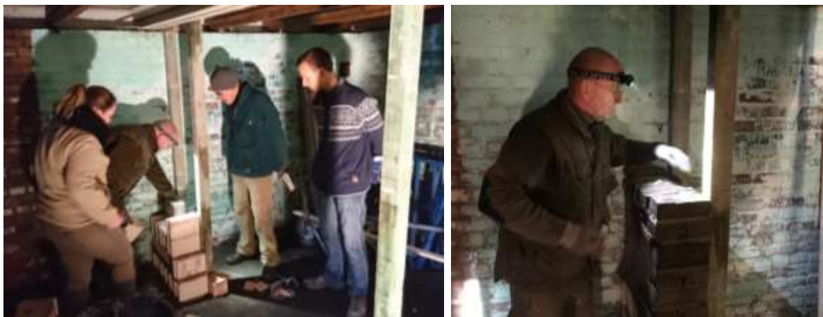
Figuur 22. In de kelder worden extra steunmuren voor het dak gemetseld, met openingen waarin vleermuizen kunnen wegkruipen (foto's Erik Korsten).
