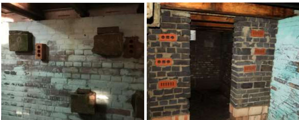
Figuur 23. Een blik op het interieur van vleermuiskelder De Blauwe Blaak, met wegkruipstenen aan de oude buitenmuren (links) en verwerkt in de steunmuren (rechts) (foto's Erik Korsten).
