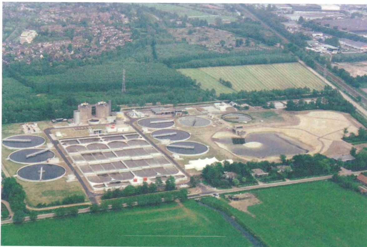
De rioolwater zuiveringsinstallatie Ede direct na het gereedkomen in 1995.
