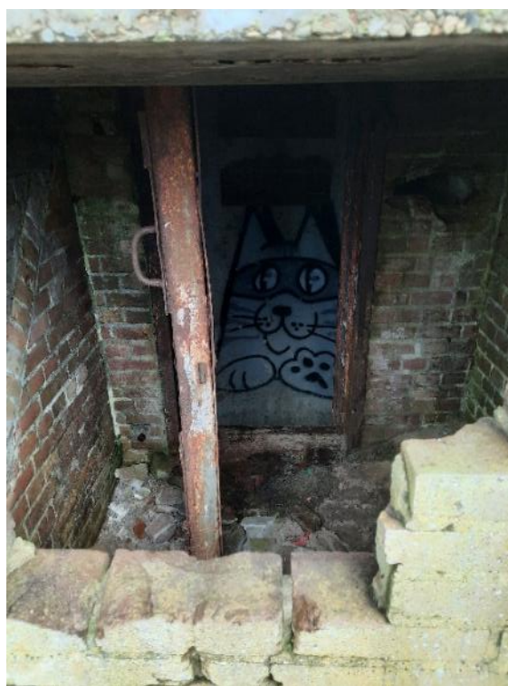
Figuur 22-19: Kelder 2, met opengebroken deur
