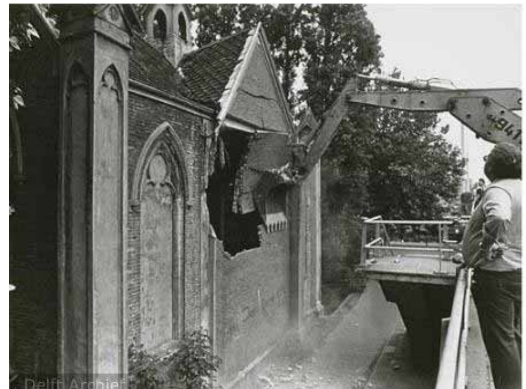
Sloop kapel van de Rooms Katholieke begraafplaats in augustus 1980. Bron: GAD
