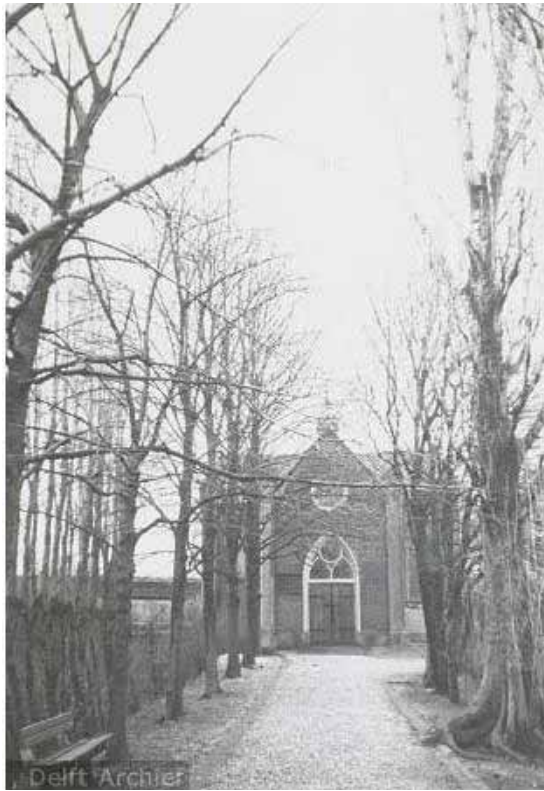
Oude lindelaan na 1960 met zicht op de niet gesloopte voorzijde van de kapel kort na aanleg van de nieuwe Sebastiaansbrug. Bron: GAD
