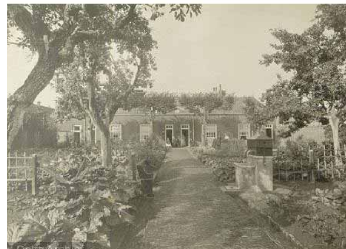
Tuinaanleg anno 1915 met middenpad, waterpomp, fruitbomen en lei-lindes langs woningen. Bron: GAD
