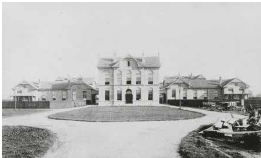
Hoofdgebouw Buitengesticht in 1894, op de achtergrond verschillende paviljoens, ontworpen door M.A.C. Hartman. Bron: GAD
