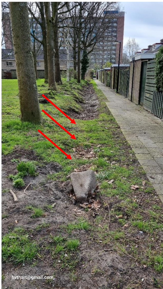
Figuur 12 Aanblik van de zonder vergunning reeds gegraven watergang aan de westzijde van de ecologische zone waarbij op de linker foto het deel laat zien waar de watergang niet gegraven kon worden vanwege de aanwezige ankerwortels die tot onder het tegelpad doorlopen (zie rode pijlen) en de rechter foto een detail laat zien van de wijze waarop het wortelgestel tot bijna op de stam is weggegraven.
