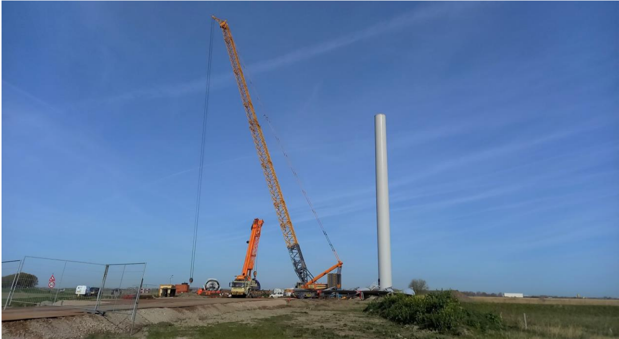
Bouw 1 e windturbine 08-04-2022
