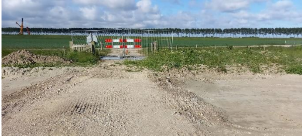
Het fietspad is afgesloten 03-05-2022
