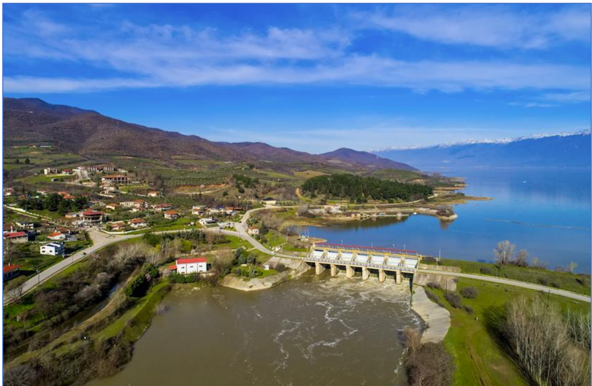
Foto 21: stuw en gemaal voor waterbeheersing en inlaat ten behoeve van land- en tuinbouw.
